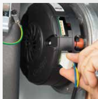
A ventilátor elektromos vezetékének kikötése
