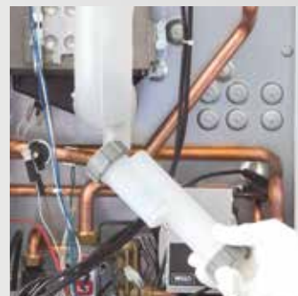
A kondenzvíz gyűjtő szifon eltávolítása
