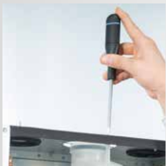
Az égéstermék-gyűjtő rögzítő csavar eltávolítása
